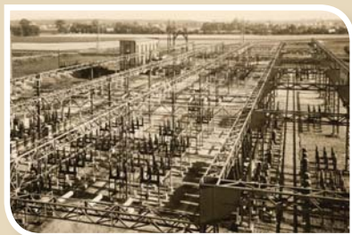
Rozvodna 110 kV v roce 1933
