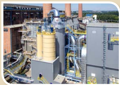
Odsíření kotle K14
