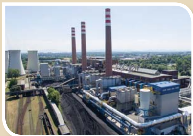
Celkový pohled na Elektrárnu Třebovice
