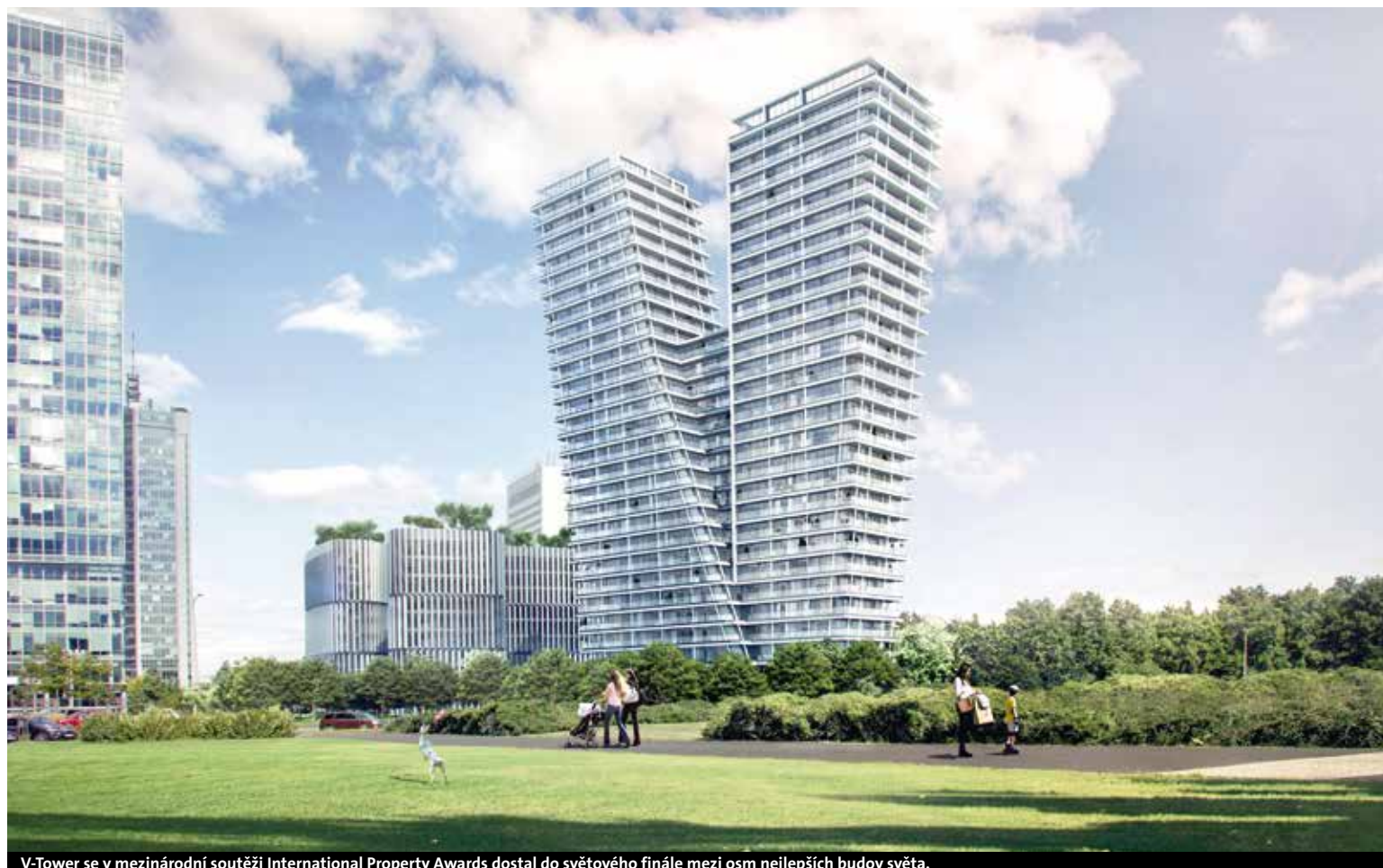
V-Tower se v mezinárodní soutěži International Property Awards dostal do světového finále mezi osm nejlepších budov světa.
